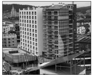
정읍 연지동 일원에 건립 중인 지하 1층·지상 11층 규모의 공공실버주택.
