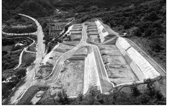
정읍시가 신내면 장금리에 국비와 시비 33억 원을 들여 '장금지구 신규마을' 20세대 택지조성 공사를 완료했다.
