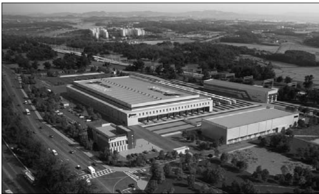
정읍시는 지난 2018년 8월 입암면 하루리(노령역) 일원에 22만1,861㎡(산업시설 143,128㎡, 주거시설 1,757㎡, 지원시설 9,617㎡, 공공시설 67,359㎡) 규모의 철도산업 농공단지 조성사업에 착수했다.
