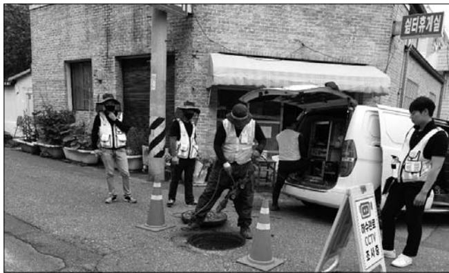
군산시 BTL하수관로 공동전수조사단은 하수관거 정비 임대형민자사업 구역 내 하수관로 100km구간에 대한 현장 실태조사를 지난 22일 완료했다.
