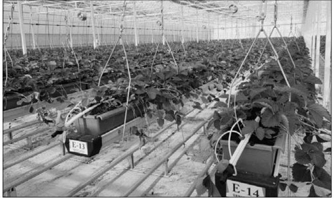
군산시가 임대한 경영실습 스마트팜은 대야면 보덕리 일원에 총면적 8,000㎡ 규모로 3연동 내재해형하우스 5동으로 조성했으며 복합환경제어시스템(ICT), 튜브레일, 양액시스템, 전기보일러 등을 갖추고 있다.
