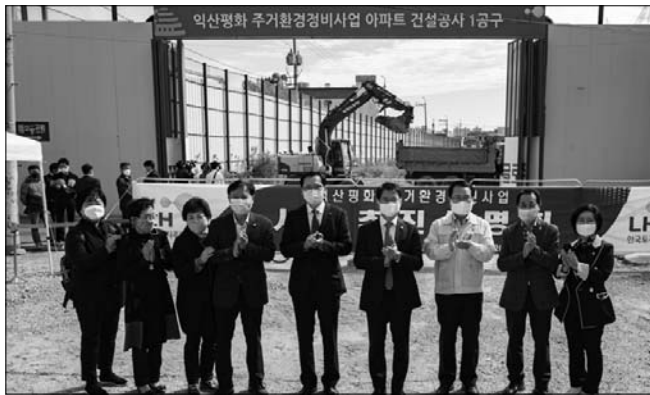
익산 평화지구 주거환경개선사업이 부지 내 매립된 오염토 처리 문제가 일단락됨에 따라 다시 본격화된다.
