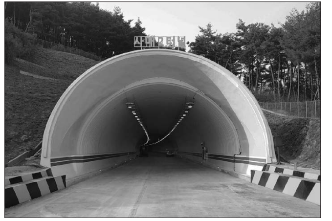
북구공사가 완료된 사매2터널 전경.
