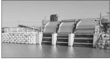
백학 2호 배수장 시공 후 유수지 전경.
