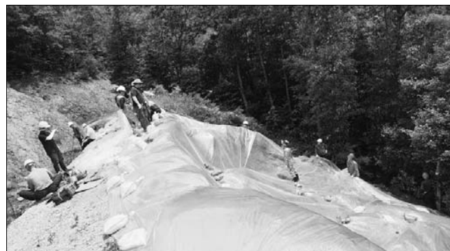
서부지방산림청은 지속적인 장마로 인해 산사태 발생위험이 높아짐에 따라 국민의 생명과 재산을 보호하기 위해 산사태취약지역 670개소 및 산림사업장을 대상으로 특별 안전점검을 시행한다.
