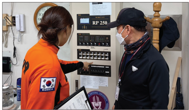
전주국제영화제 대비 화재안전 조사 전주덕진소방서가 제27회 전주국제영화제 '안전하고 성공적인 개최를 지원하기 위해 행사 전반에 걸친 소방안전대책을 추진하고 있는 가운데, 소방서 관계자들이 화재안전 조사에 나서고 있다. <사진=전주덕진소방서 제공>
