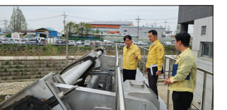
배수펌프장 등 방재시설 운영 상태 △ 강우계 및 도로수위계 등 예·경보시설 운영 실태 등이다.
