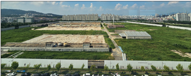
전주시 효자동 서부신시가지 내 옛 대한방직 부지 개발을 위한 건축물 철거공사가 본격화된다.
