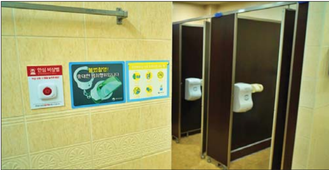
안심 비상벨과 칸막이 안심 기립막이 설치된 완산체련공원 공중화장실
