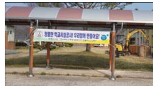
적성초 공사현장 청렴홍보 현수막
