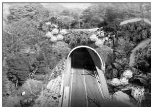
지의 기후와 토양에 맞는 현지 자생식물을 심어 끊겼던 산림 식생을 되살리고, 생태통로는 야생동물의 로드킬을 막고 안전한 이동을 돕는 터널형으로 조성된다.
