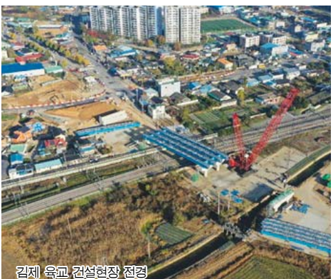
김제 육교 건설현장 전경
