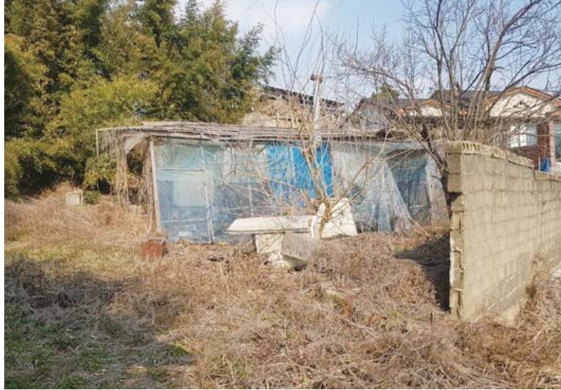
백산면 상리 철거 전(사진 왼쪽)과 철거 후의 모습.
