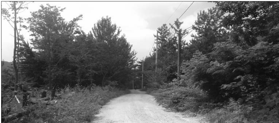
고창군이 유네스코 생물권보전지역의 핵심지역이자 국가생태관광지역인 운곡습지 일원에 한국전력공사와 공동으로 전선 지중화 사업을 본격 추진한다.
