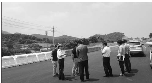
피서철을 앞두고 임시개통 되는 새만금전시관부터 변산면 변산교차로 구간(3.8km)에 대해 현장 점검을 했다.
